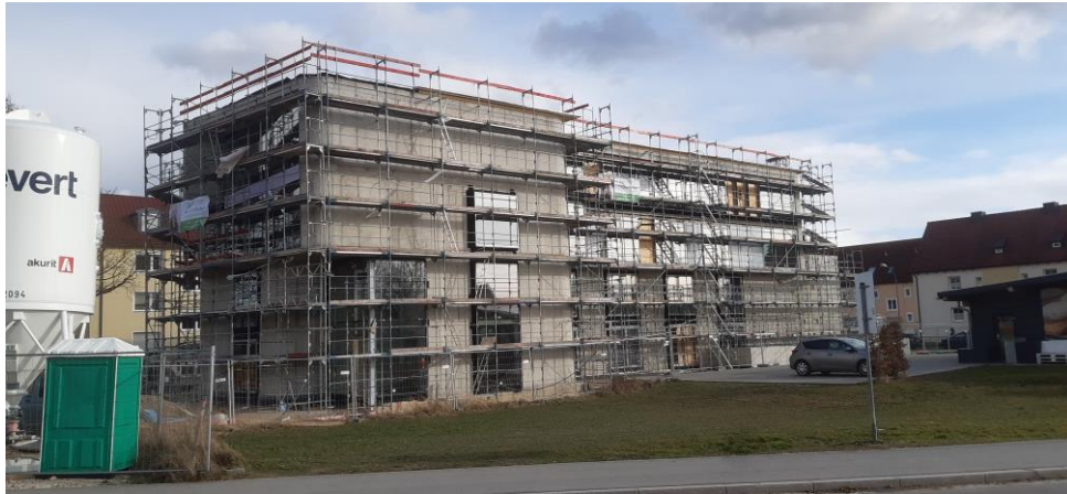
In der Augsburger Straße / Am Neufeld entsteht ein modernes Bürogebäude.
