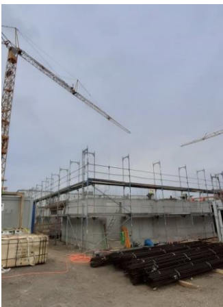
In der Franz-Boecker-Straße wächst seit kurzer Zeit ein Gewerbebau.
