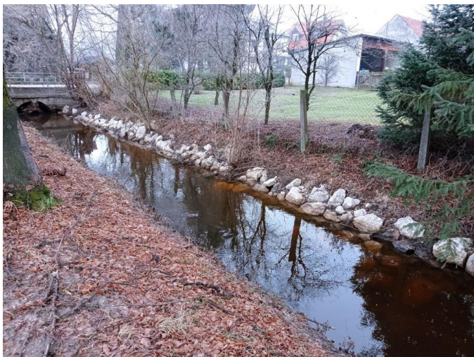
Böschungssicherung mit Wasserbausteinen am Zeller Kanal
