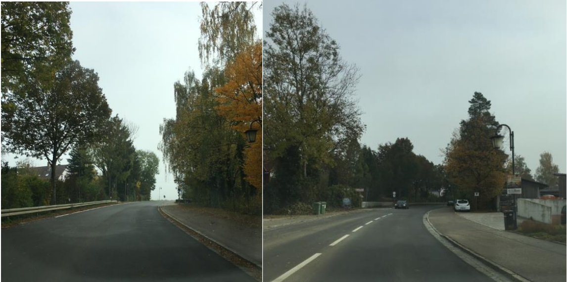
Sanierung der Ingolstädter Straße stadtauswärts bis Bergheim:
