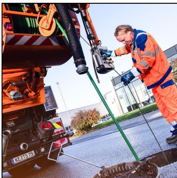
Spülwagen bei der Kanalreinigung (beispielhaft)
