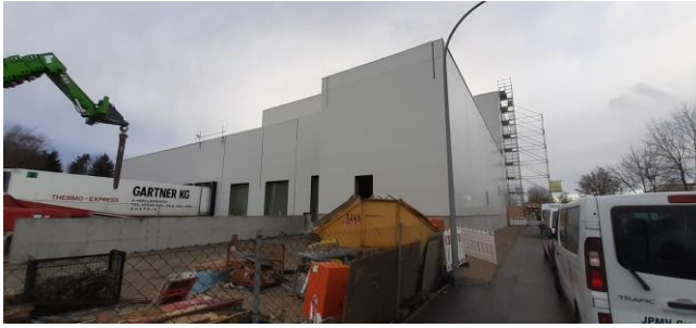
In der nördlichen Grünauer Straße wird das Hochregallager und der Verladebereich eines großen Lebensmittelbetriebes erweitert.
