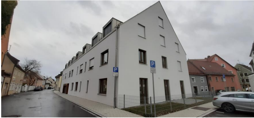
Im Bereich der Schießhausstraße wurde das Mehrfamilienwohnhaus fertiggestellt und prägt nun die neue Platzsituation.
